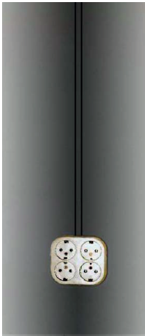
Figuur 6-3. Stralend muurvlak. De kabels achter het stucwerk veroorzaken voor de muur een sterk elektrisch veld.
