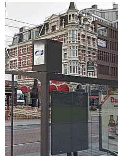
Figuur 4. Small cell op tramhalte Rembrandtsplein Amsterdam Bron: Google Maps.
